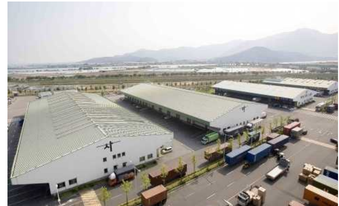
<그 24> 대한통운 복합물류 터미널 지붕
