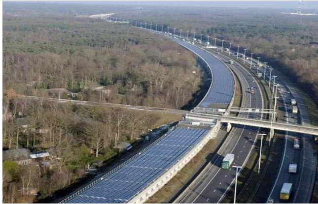
<그림 9> 벨기에의 터널에 설치된 태양광 터널
