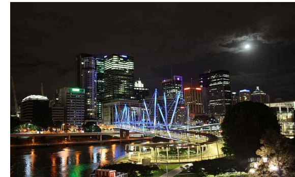
<그림 8> Kurilpa 교량에 설치된 태양광 시설
