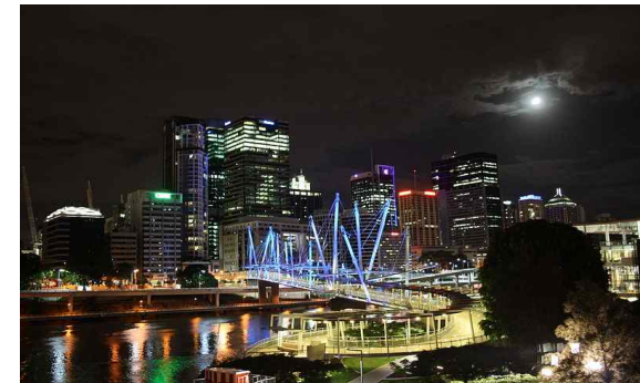
Kurilpa 교량에 설치된 태양광 시설
