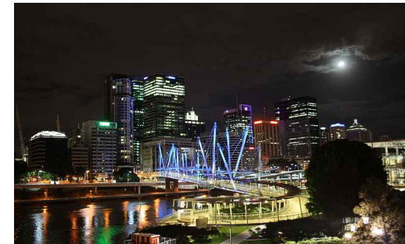
<그림 8> Kurilpa 교량에 설치된 태양광 시설
