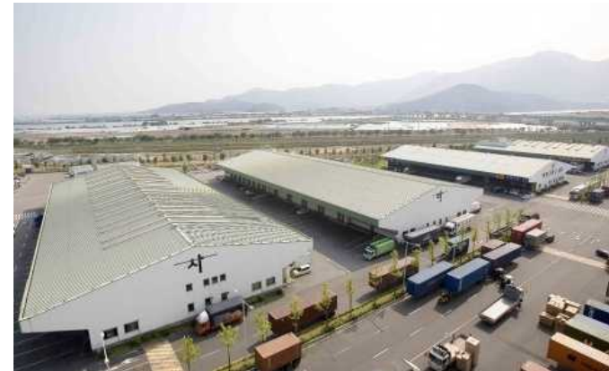
<그 24> 대한통운 복합물류 터미널 지붕
