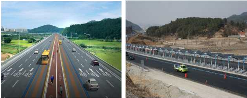
<그 15> 세종시에 건설중인 중 분리대 형식의 첨단 자전거도로
