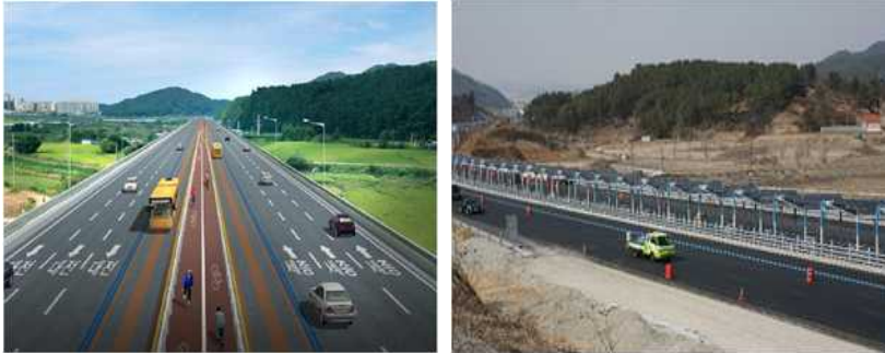
<그림 15> 세종시에 건설중인 중앙분리대 형식의 첨단 자전거도로
