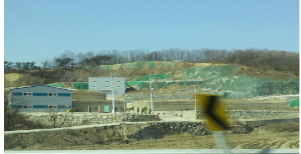
<주변지역과 부조화> 무분별한 산지 절토에 따른 주변지역과 부조화
