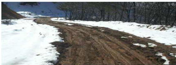
국도 59호선 강릉 연곡-양양 현북 구간 (미포장 도로 : 국도 + 지방도 = 9,536km)
