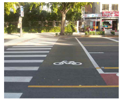
자전거 횡단로 설치
