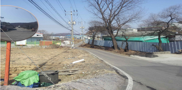
<기반시설 부족> 약 10만㎡ 공장 등의 입주 지역에 폭 3.5m 진입도로 설치
