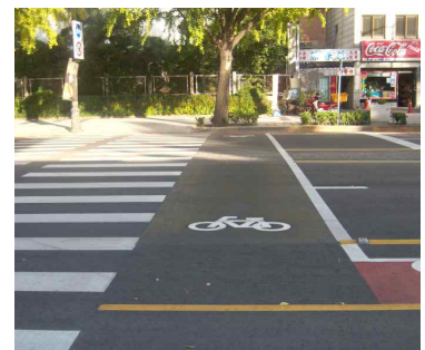
자전거 횡단로 설치
