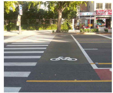
자전거 횡단로 설치
