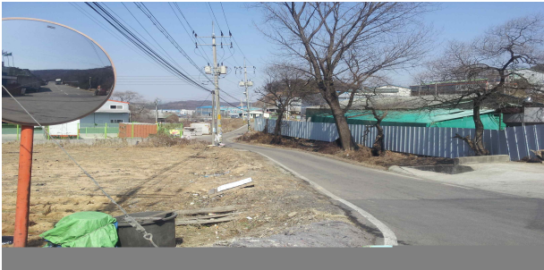
<기반시설 부족> 약 10만m 2 공장 등의 입주 지역에 폭 3.5m 진입도로 설치
